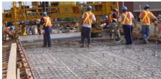
Coulée des dalles
